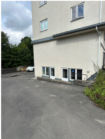
Lokalet til høyre i bilde med dør og vindu.
