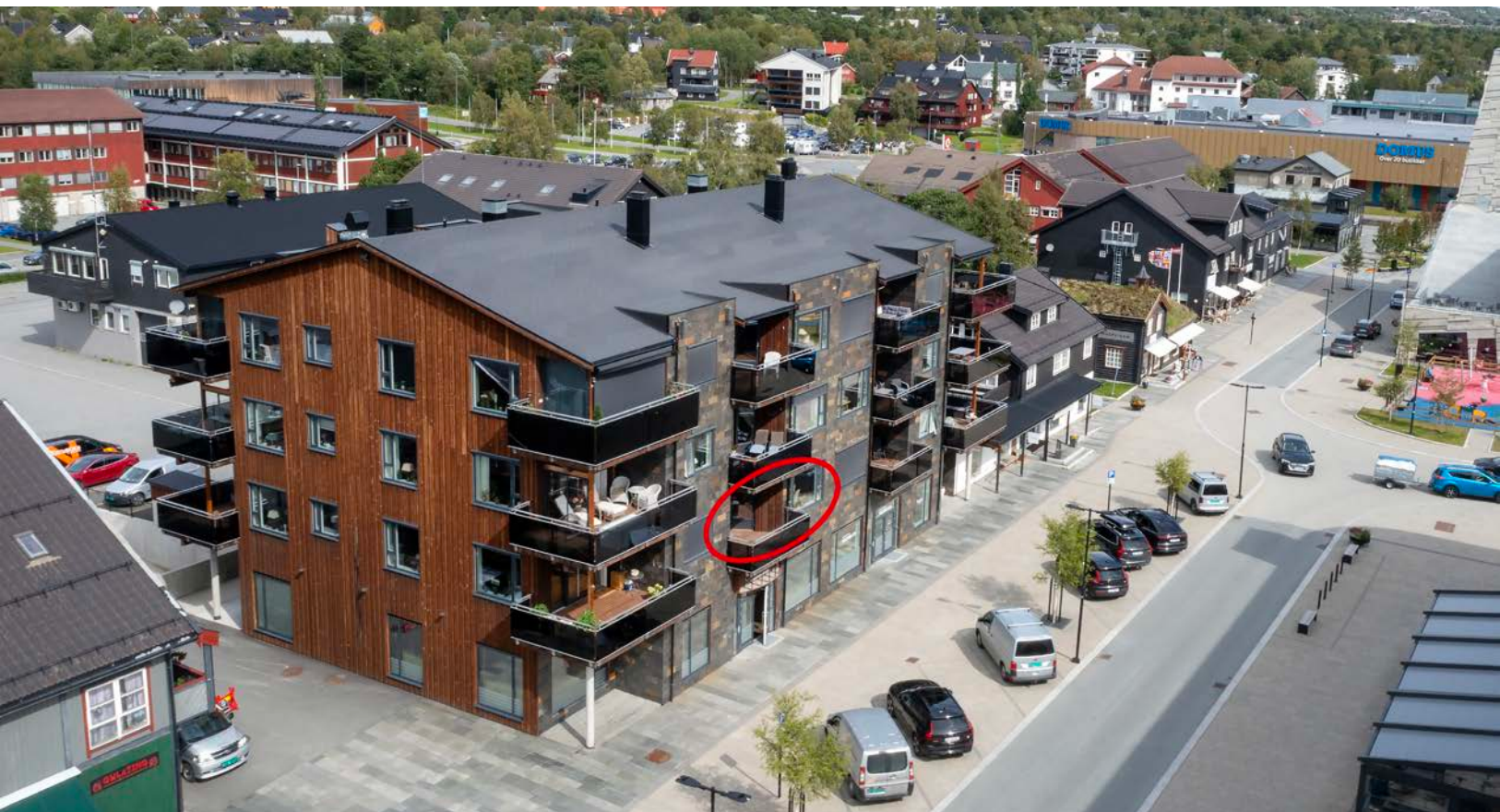
Fasade med markering
