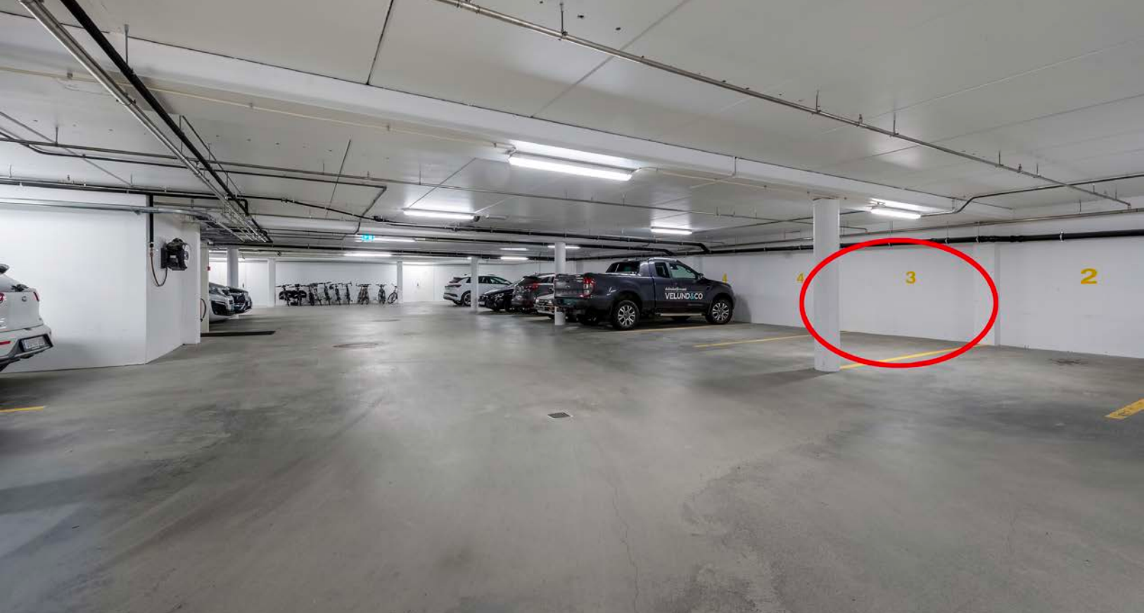
Parkeringskjeller med merking av p plass
