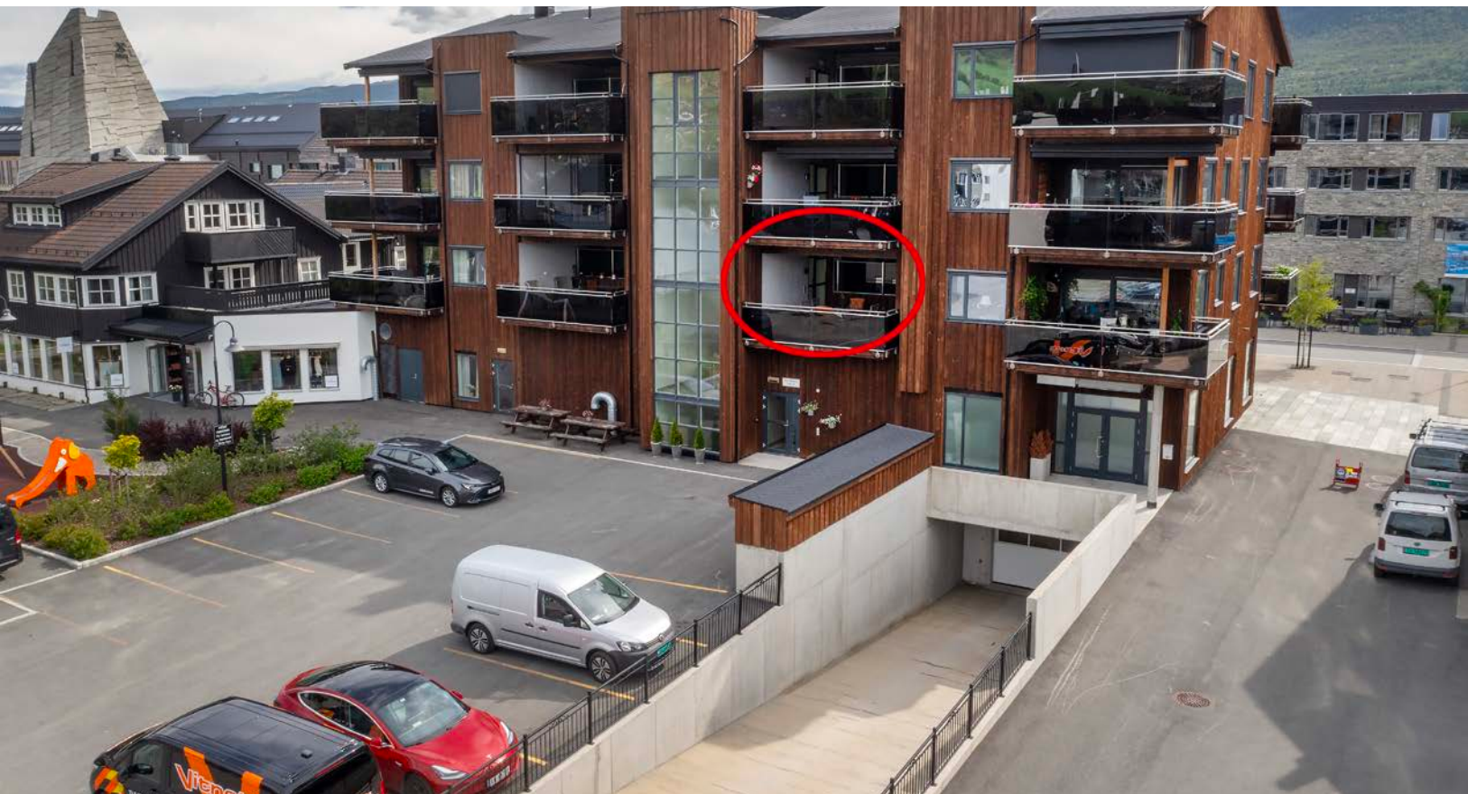
Fasade og nedkjøring til parkeringskjeller
