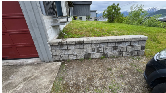
Støttemur av betongstein.
