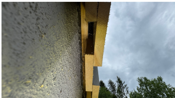
Det er ingen musesperre i nedre kant av konstruksjon.
