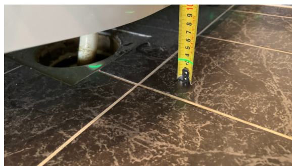
Kontroll av fallforhold.
