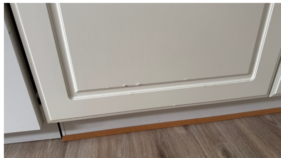
Innredningen har noe slitasje.
