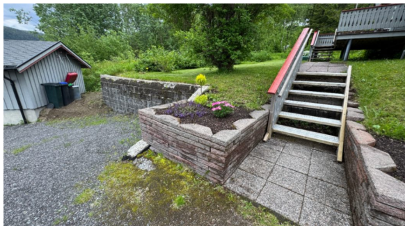
Støttemur av betongstein.
