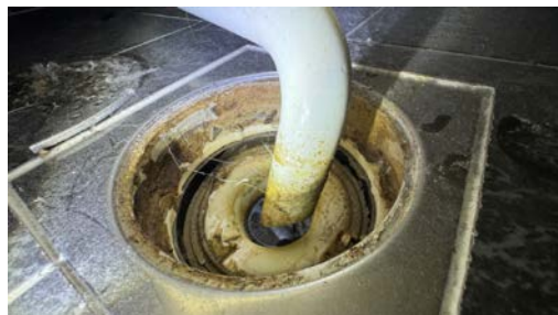
Kontroll av sluk.
