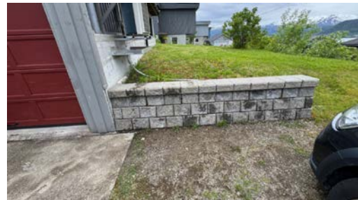
Støttemur av betongstein.
