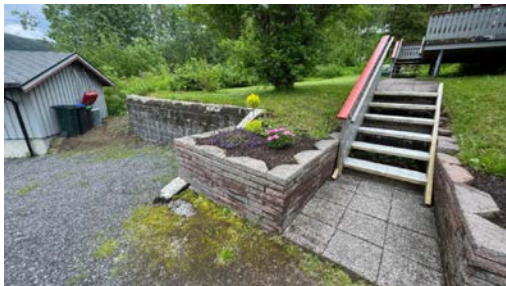
Støttemur av betongstein.
