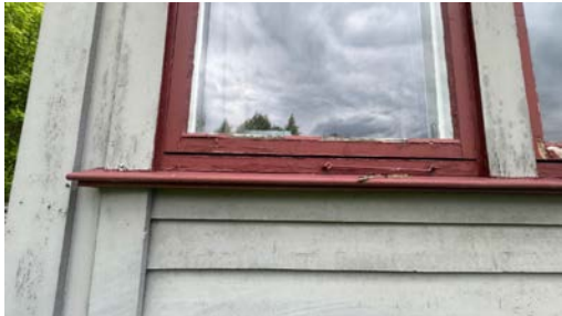
Karmene i vinduer er slitte og det er sprekker i treverket.
