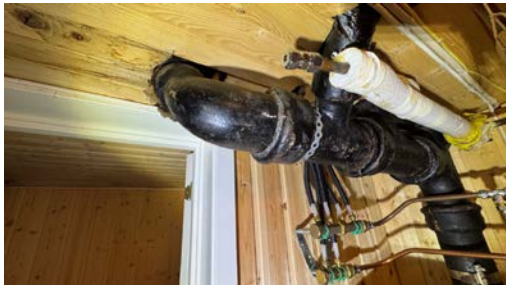
Det er eldre avløpsrør av soil.
