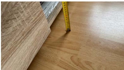
Kontroll av planavvik.
