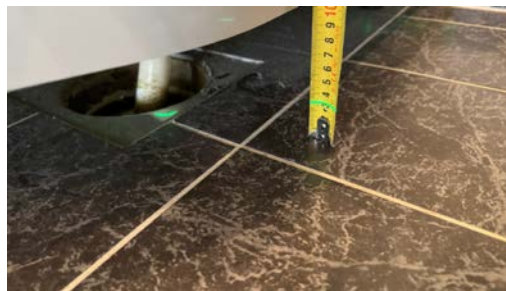
Kontroll av fallforhold.
