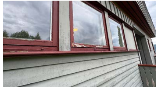
Karmene i vinduer er slitte og det er sprekker i treverket.
