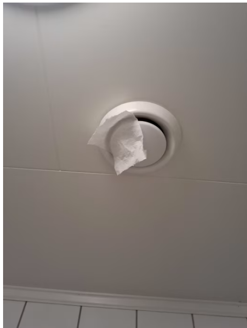
Avtrekkseffekt ble testet med papir.
