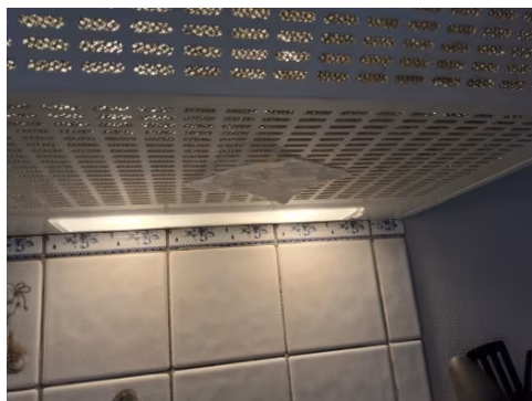
Avtrekkseffekten er testet med papir.
