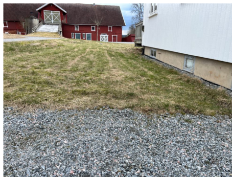
Terrengfall mot grunnmur østvegg
