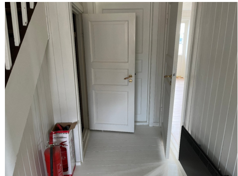
En side av piper tildekket med vegg/panel.
