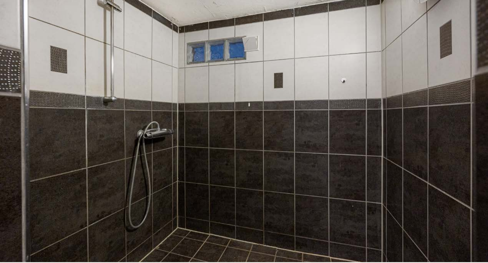
Bildet viser dusjrommet i kjelleren.
