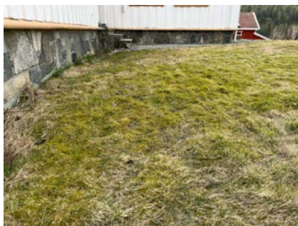
Terreng faller mot grunnmur
