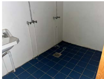
Manglene membran på gulv/vegger
