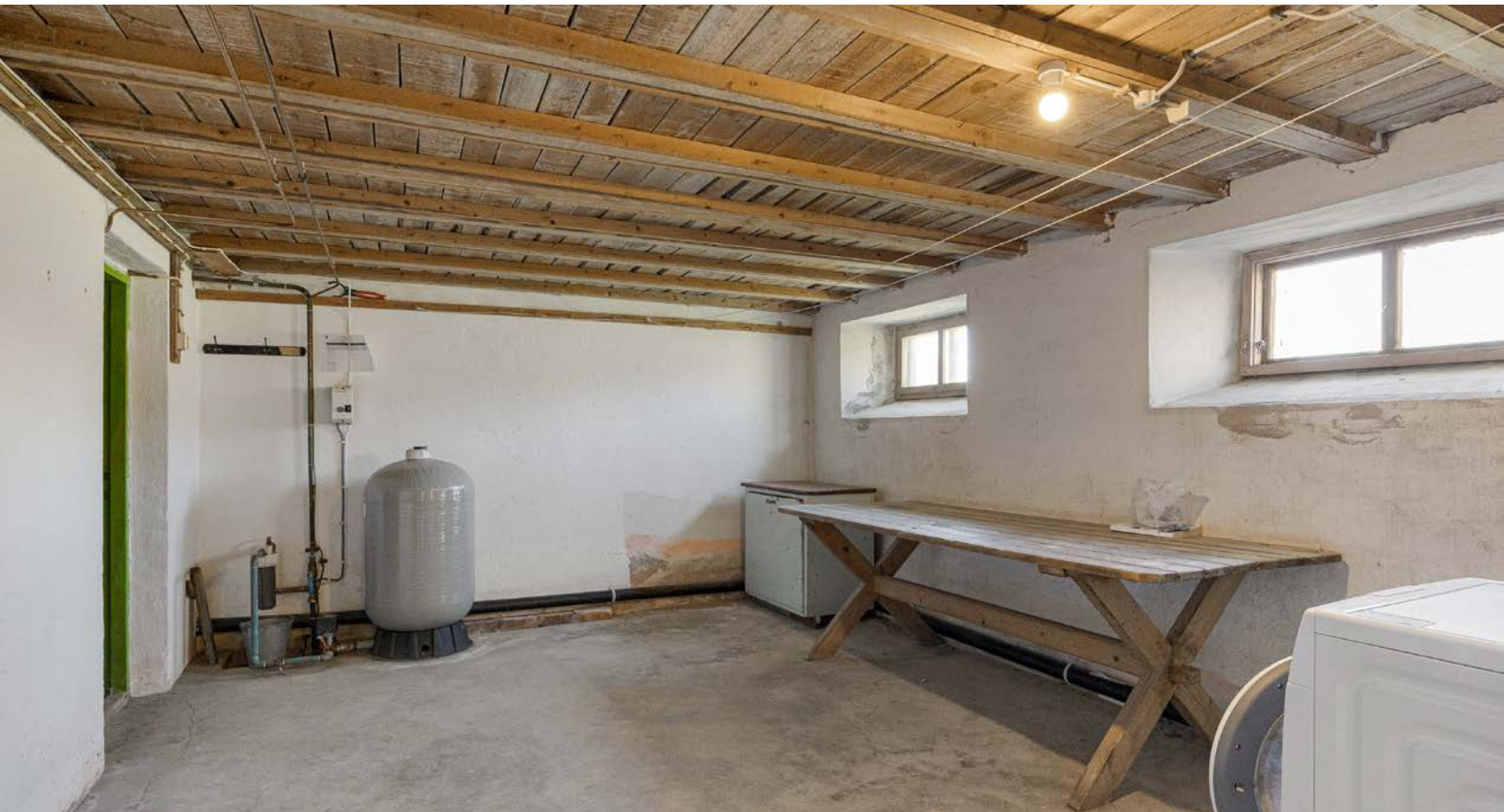
Bildet viser vaskerommet i kjelleren.
