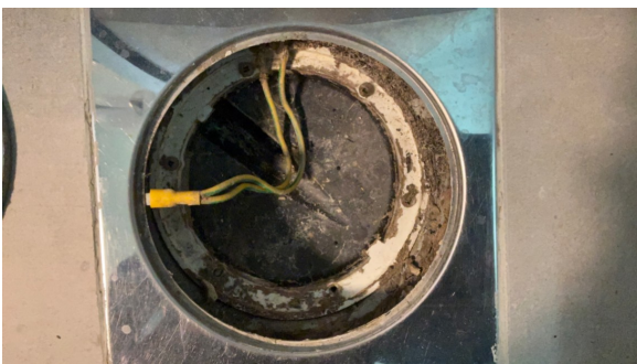
Kontroll av sluk.
