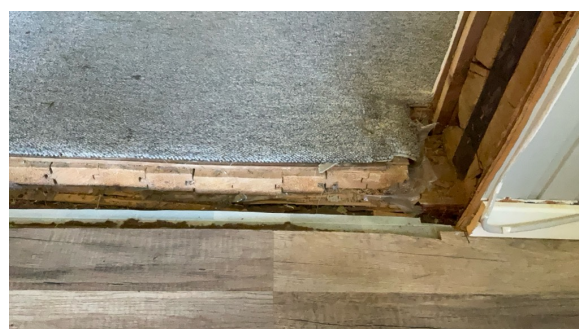
Endel uferdige arbeider gjenstår.
