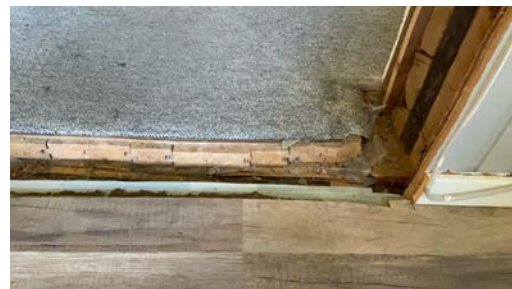
Endel uferdige arbeider gjenstår.
