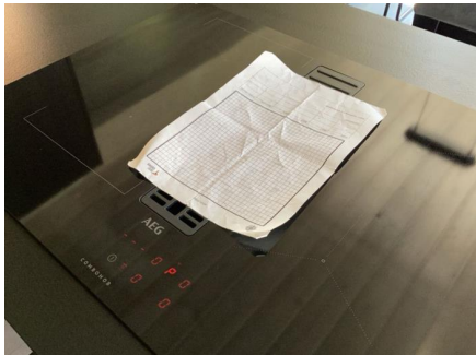
Ved test av avtrekksvifte som beskrevet i NS3600, fungerte viften som tiltenkt.
