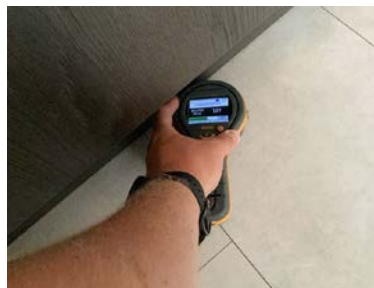
Ved bruk av fuktindikator registrerte jeg ingen unormale verdier.
