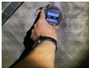
Ved enkle fuktsøk med fuktindikator registrerte jeg unormale verdier.
