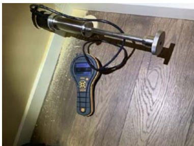
Fuktmåling ble foretatt, jeg målte tørre verdier i konstruksjon.
