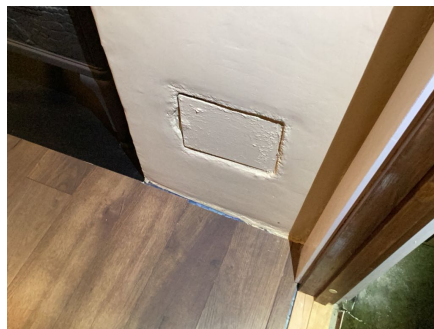
Feieluke på kjellerstue i kjeller.
