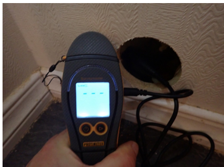
Ingen skadelig fukt i hulltakingen
