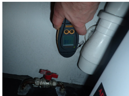
Ingen avvik ved fuktsøk i utsatte soner.
