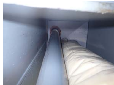
Utettheter i luftelyre / kloakklufting.
