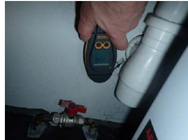
Ingen avvik ved fuktsøk i utsatte soner.
