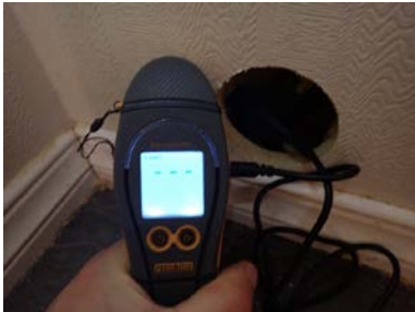
Ingen skadelig fukt i hulltakingen
