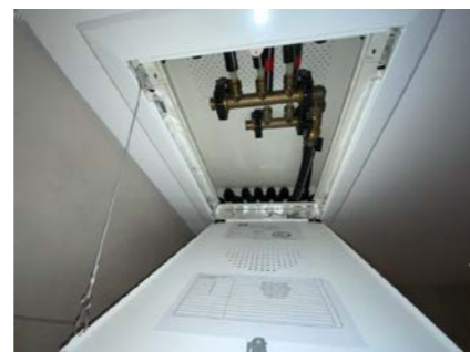
Besiktigelse av røropplegg.
