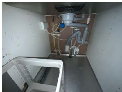
Besiktigelse av røropplegg.
