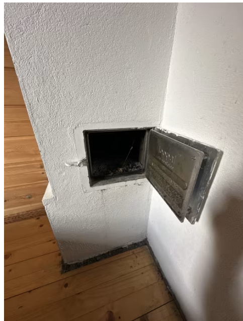
Viser sotluke. Ildfast plate montert etter befaring.
