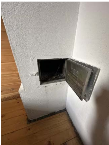
Viser sotluke. Ildfast plate montert etter befaring.
