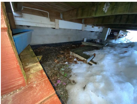
Kontroll av drenering/fuksikring.
