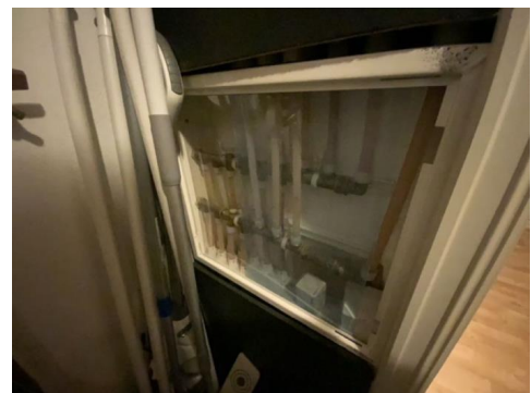
Besiktigelse av røropplegg.
