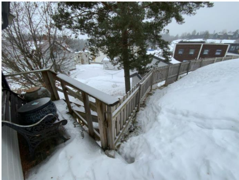
Kontroll av utvendige rekkverk.
