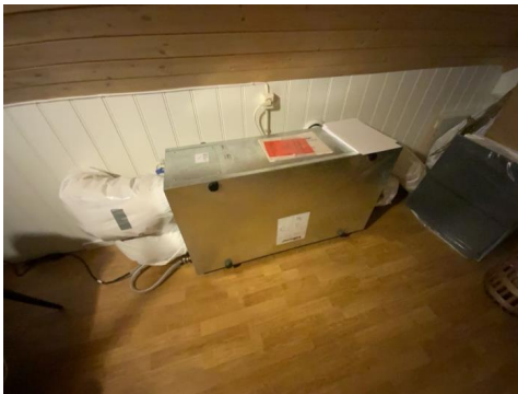
Besiktigelse av sentral.
