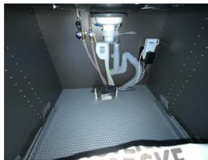
Besiktigelse av røropplegg.
