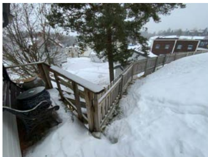
Kontroll av utvendige rekkverk.
