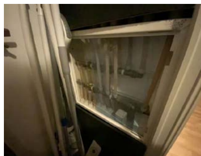
Besiktigelse av røropplegg.
