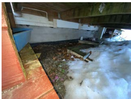
Kontroll av drenering/fuktsikring.
