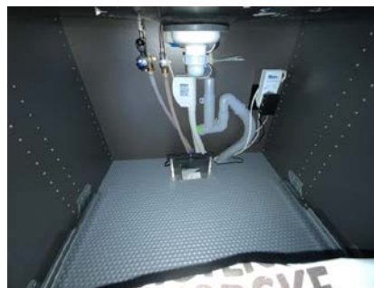
Besiktigelse av røropplegg.
