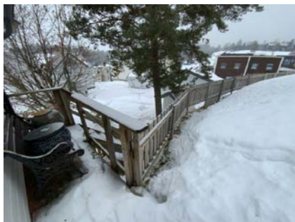
Kontroll av utvendige rekkverk.
