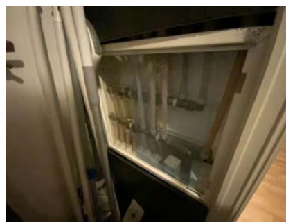
Besiktigelse av røropplegg.
