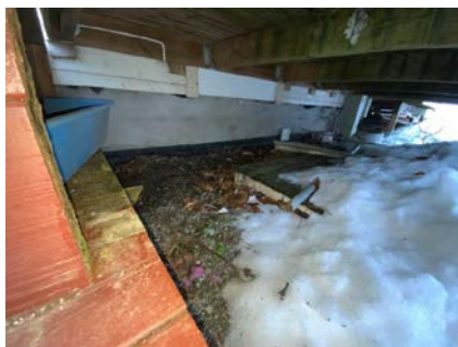
Kontroll av drenering/fuktsikring.
