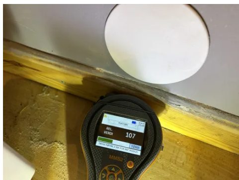
Ingen tegn til skader eller fukt i konstruksjonen.
