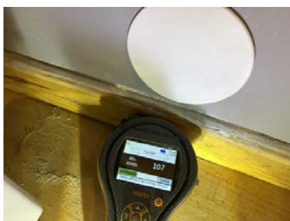
Ingen tegn til skader eller fukt i konstruksjonen.
