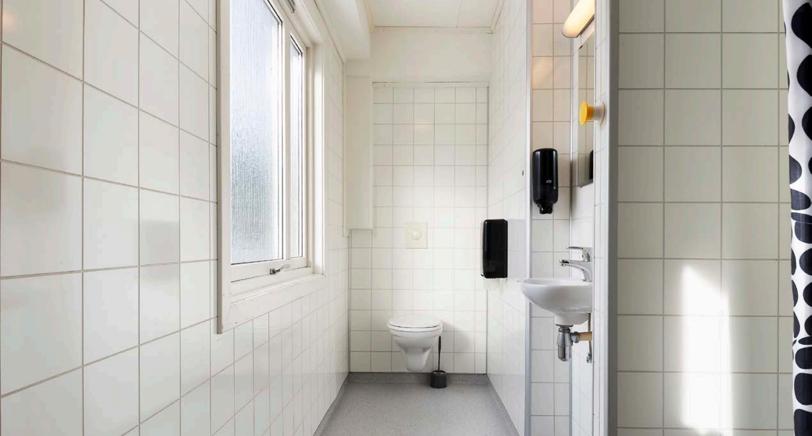
Bad med lyse overflater.
