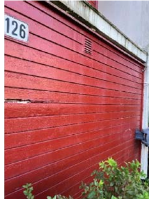
Fasade ved inngangsparti
