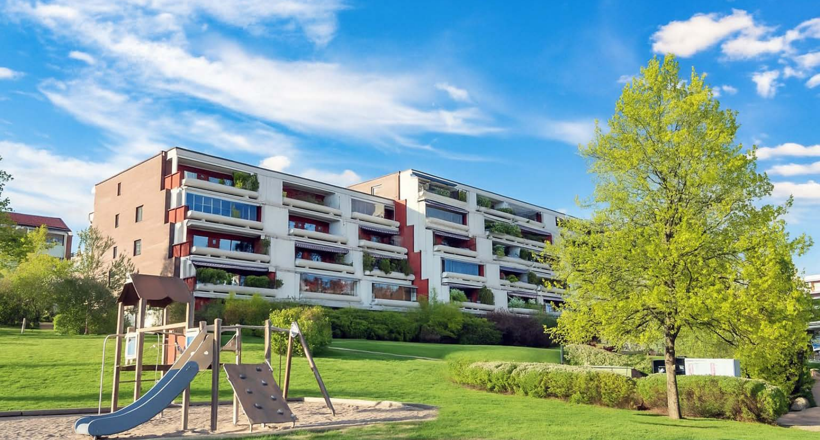
Bilde av fasade før rehabilitering (Innglassing på sydsiden forsvinner).
