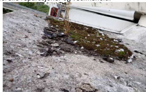
Topp av bodvegg uten overflatebehandling
