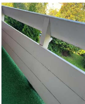
Rekkverk på balkongside
