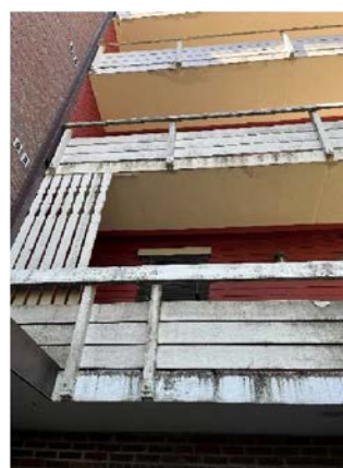
Rekkverk på balkongside
