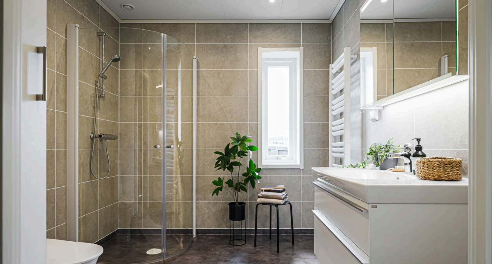
Moderne baderom 1 fra 2024 med belegg på gulv med gulvvarme, våtromsplater på veggene, downlights i himlingen og balansert ventilasjon. Håndklehenger med vannbåren varme.
