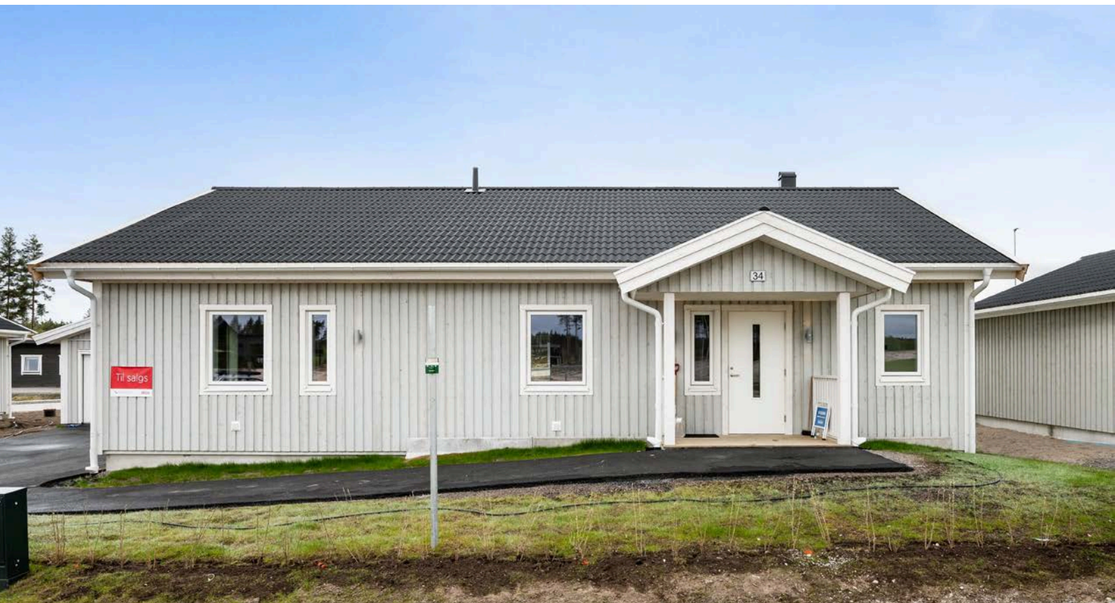
Tomten er opparbeidet med asfaltert innkjørsel.
