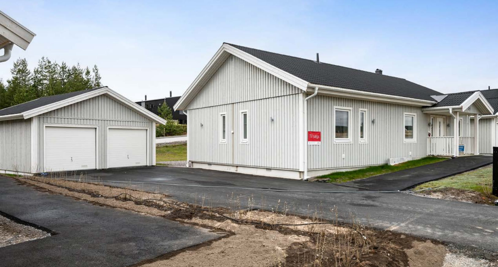
Praktisk dobbelgarasje med asfaltert gulv innvendig.
