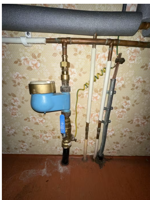
Viser vanninntak, hovedstoppekran og vannmåler på vaskerom i kjeller.
