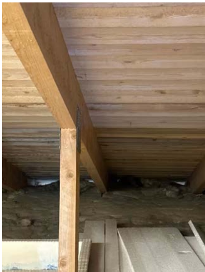
Tiltenkt luftespalte ved raft er redusert.
