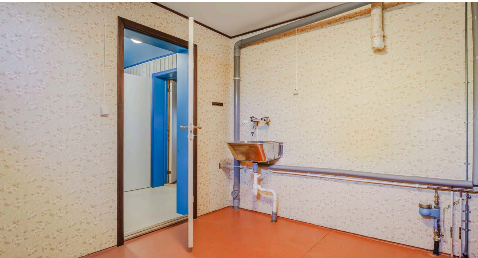
Vaskerommet har belegg på gulv, tapet på veggene og er utstyrt med utslagsvask, åpne hyller og varmtvannsbereder.
