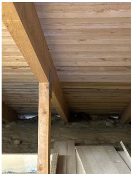
Tiltenkt luftespalte ved raft er redusert.
