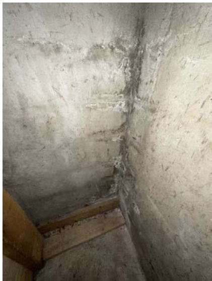
Det registreres mineralutslag (salt/kalkutslag) i overflater som er et symptom på fuktvandring gjennom grunnmur.
