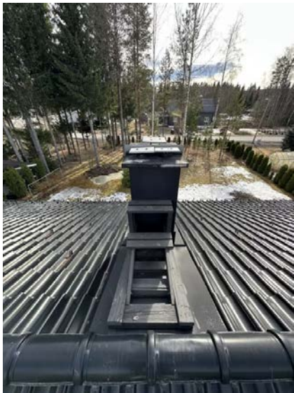
Helbeslått pipe over tak.
