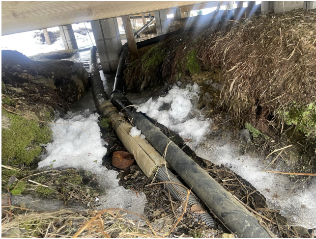
Utilstrekkelig avskjæringsgrøft.
