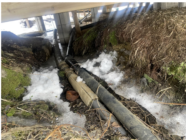
Utilstrekkelig avskjæringsgrøft.
