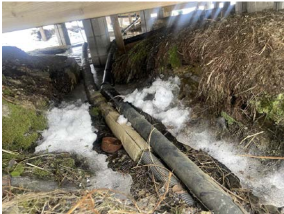
Utilstrekkelig avskjæringsgrøft.
