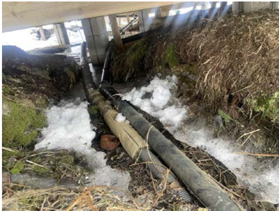
Utilstrekkelig avskjæringsgrøft.
