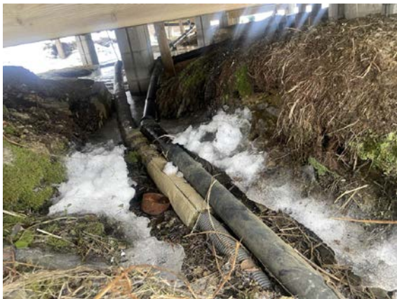
Utilstrekkelig avskjæringsgrøft.
