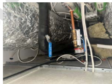
Stoppekraner plassert i felles gang.
