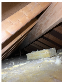
Etterisolert på horisontal del av takkonstruksjonen
