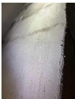
Inspeksjon av 2 sider på pipen mulig via åpningen
