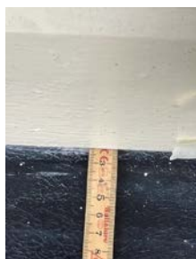
Beslag ligger med oppbrett direkte bak bordkledningen.
