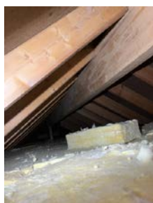
Etterisolert på horisontal del av takkonstruksjonen
