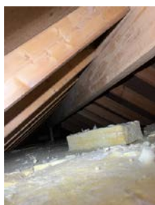
Etterisolert på horisontal del av takkonstruksjonen
