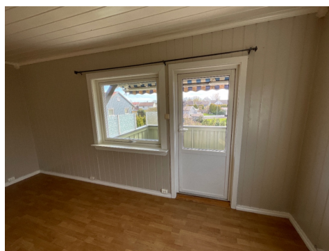
Balkongdør og stuevindu
