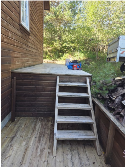
Rekkverk mangler.
