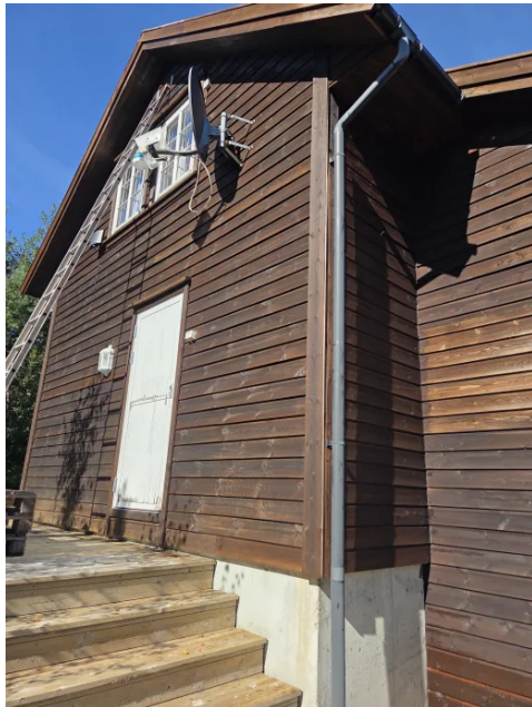
Rekkverk/håndløper mangler.
