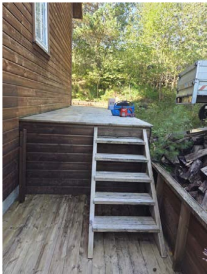
Rekkverk mangler.
