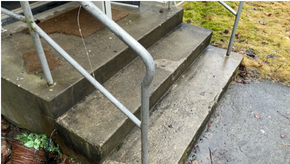
Betongtrapp med rekkverk i stål.
