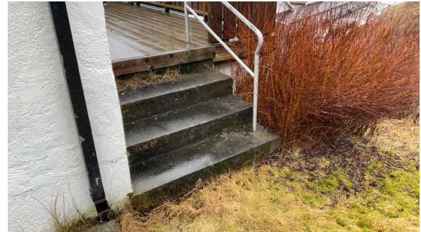
Trapp til veranda.
