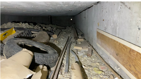
Krypkjeller under betongdekke
