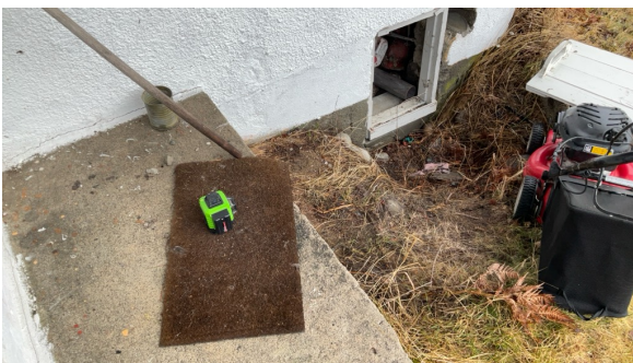
Nedsenking i terreng ved adkomst til krypkjeller.
