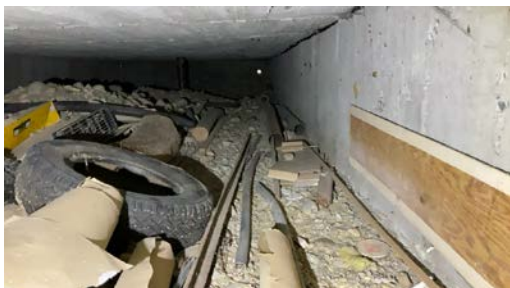
Krypkjeller under betongdekke
