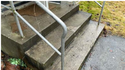
Betongtrapp med rekkverk i stål.
