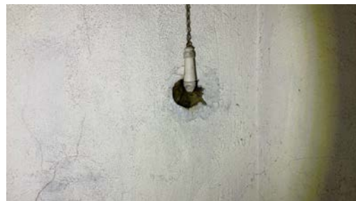
Utett pipe etter at en ovn er fjernet.
