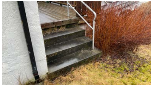
Trapp til veranda.
