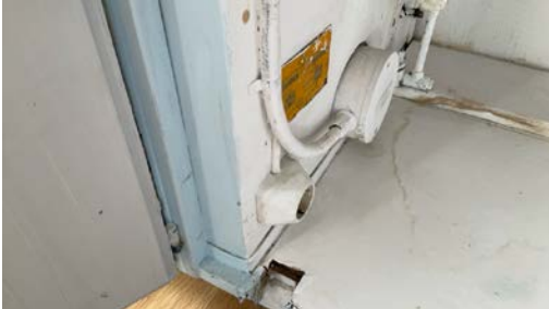
Ca 20l bereder i kjøkkenbenk i underetasjen.
