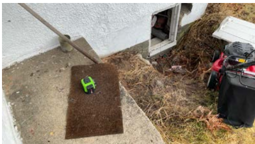
Nedsenking i terreng ved adkomst til krypkjeller.
