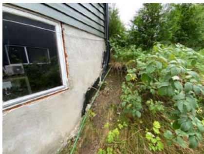
Kontroll av drenering/fuktsikring.
