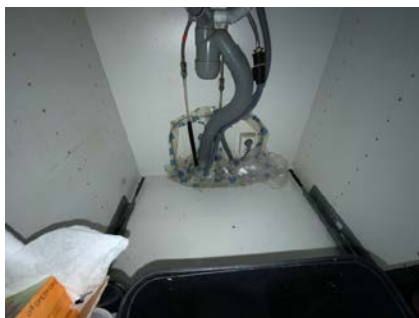
Besiktigelse av røropplegg.
