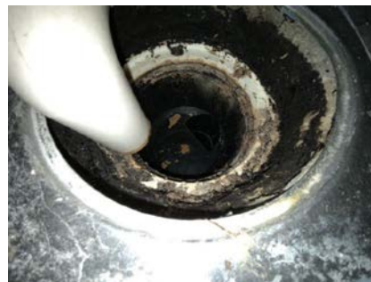
Kontroll av sluk.
