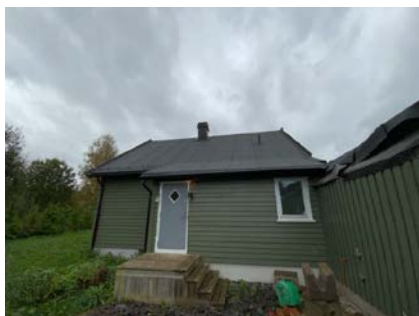
Besiktigelse av taktekke.
