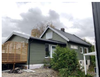
Besiktigelse av taktekke.
