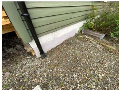
Kontroll av drenering/fuktsikring.
