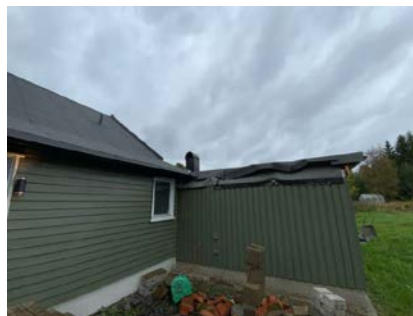
Besiktigelse av taktekke.
