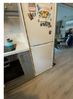
Front på integreert kjøleskap mangler. Noe ulyd fra kjøøl/frys.
