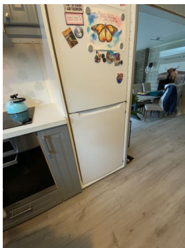
Front på integrert kjøleskap mangler. Noe lyd fra kjølfrys.
