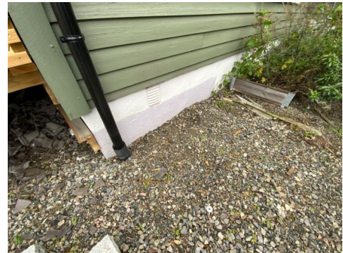
Kontroll av drenering/fuktsikring.
