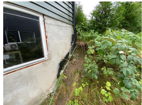
Kontroll av drenering/fuktsikring.
