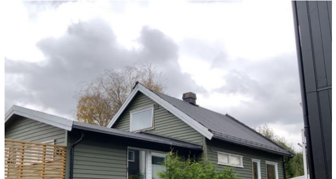
Besiktigelse av taktekke.
