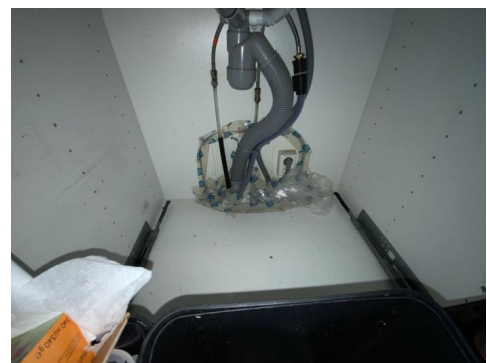
Besiktigelse av rørpropplegg.
