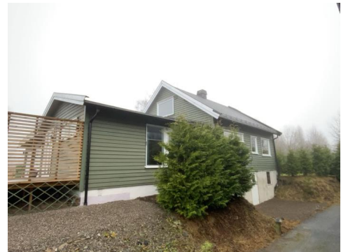
Besiktigelse av taktekke.
