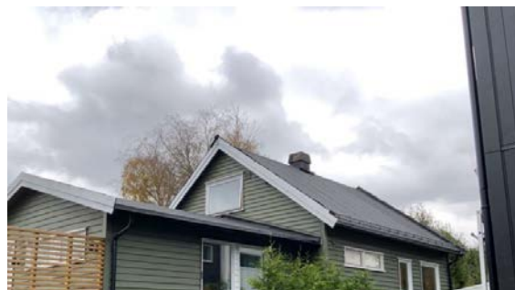
Besiktigelse av taktekke.
