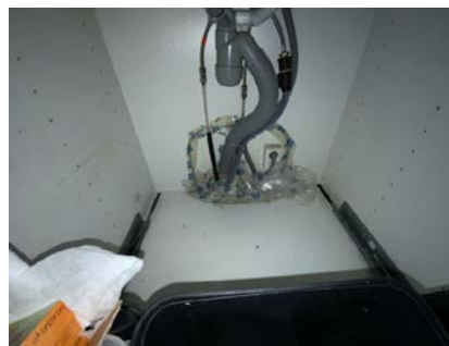
Besiktigelse av røropplegg.
