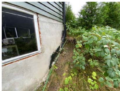
Kontroll av drenering/fuktsikring.
