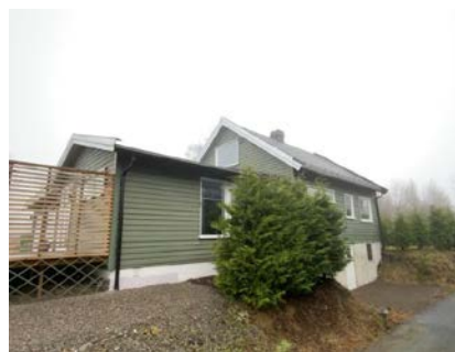
Besiktigelse av taktekke.
