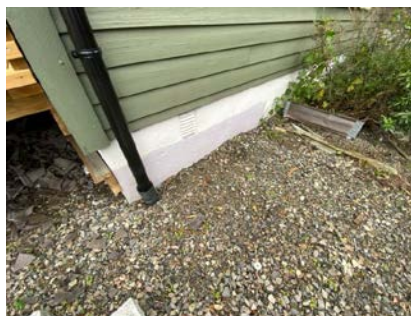
Kontroll av drenering/fuktsikring.
