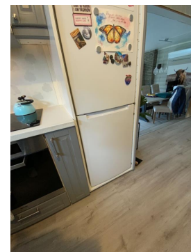
Front på integrert kjøleskap mangler. Noe lyd fra kjøøl/frys.
