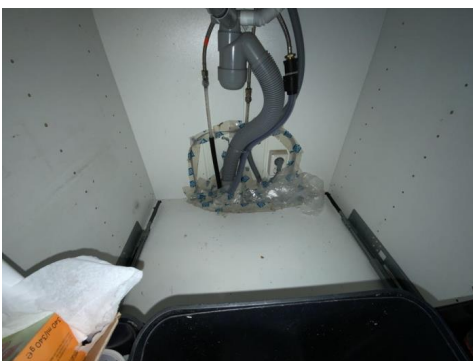
Besiktigelse av røropplegg.
