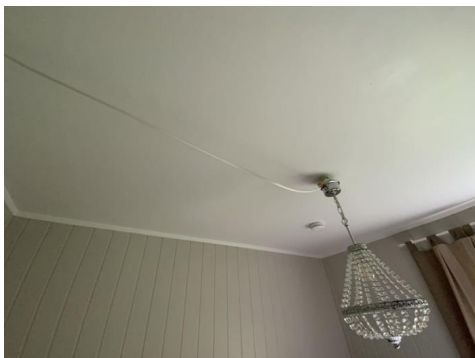
Lampeledning på soverom i 1.etg må festes.
