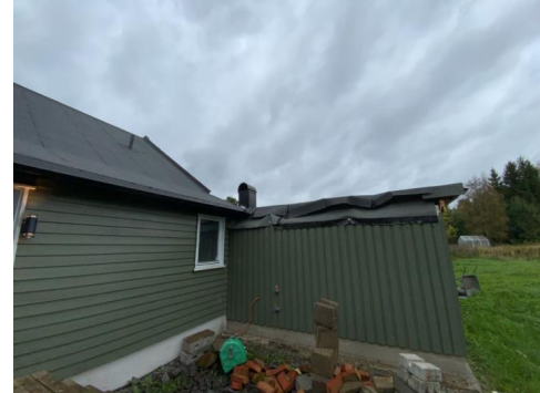
Besiktigelse av taktekke.
