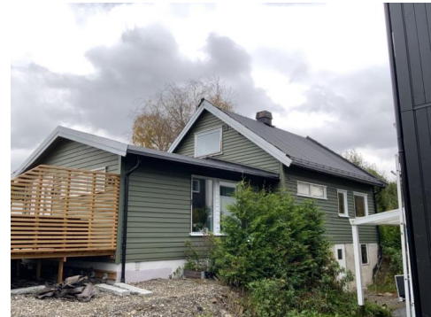
Besiktigelse av taktekke.
