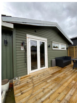
Høyde opp fra terrasse til terskel er noe lav der metallrist bør felles ned for tilfredsstillende avrenning.
