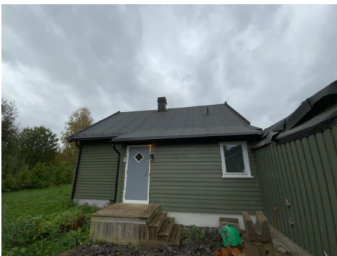
Besiktigelse av taktekke.
