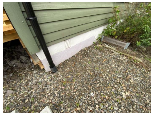
Kontroll av drenering/fuktsikring.
