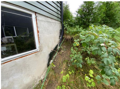
Kontroll av drenering/fuktsikring.
