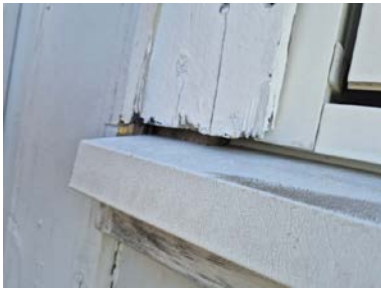
Ingen oppkant av beslag bak list.
