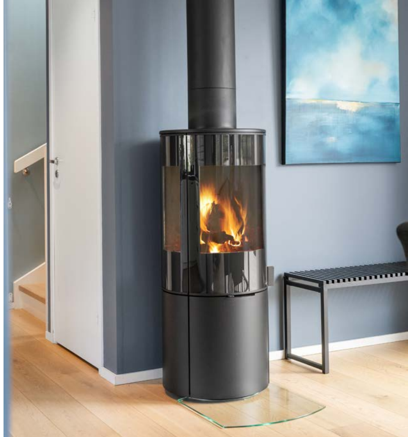
Stålpipe med ildsted montert i 2025 - Bod under trapp som gir ekstra lagring.
