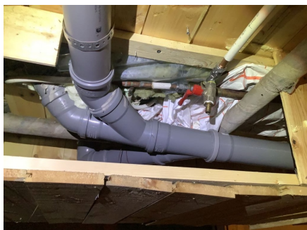
Avløpsrør under våtrom 1. etasje, synlig fra kjeller.
