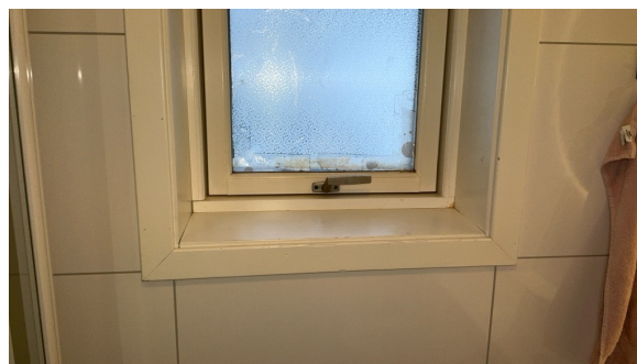
Vindu plassert i våtsone.
