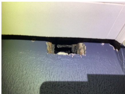
Åpning/hull i pipeløp.
