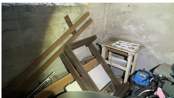
Organiske materialer ligger direkte mot grunn/mur.
