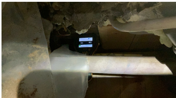
Fuktmåling i treverk, ingen forhøyede verdier er målt.
